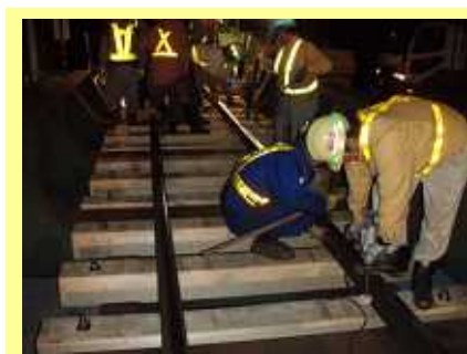
田川橋りょうまくら木交換 信号高圧絶縁電線化工事
