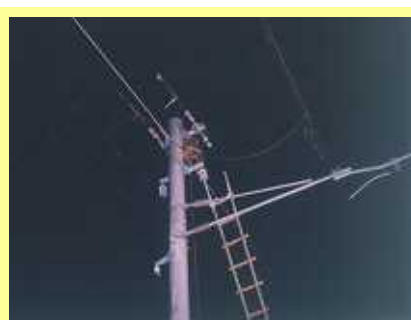
田川橋りょうまくら木交換 信号高圧絶縁電線化工事
