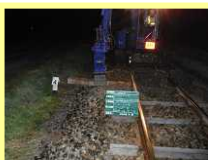
まくら木交換工事
