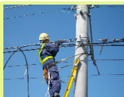
通信ケーブル張替工事
