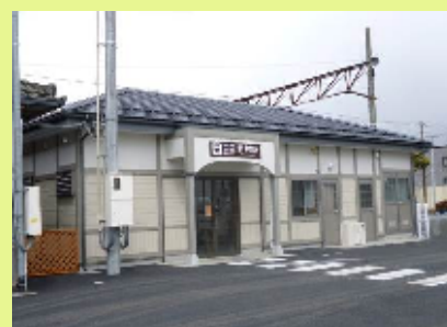
駅舎建替（新村駅）
