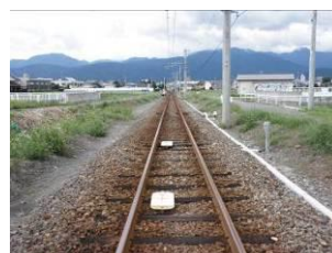
自動列車停止装置新設
