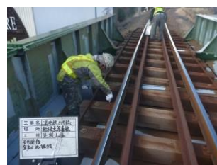
橋りょう整備
