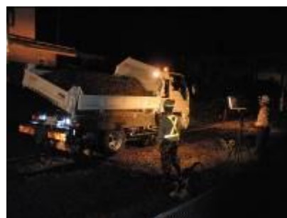
夜間軌道整備作業
