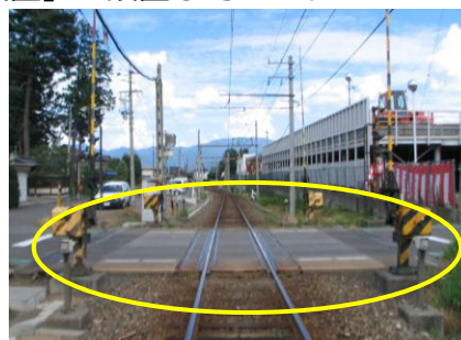
赤外線式踏切障害物検知装置
