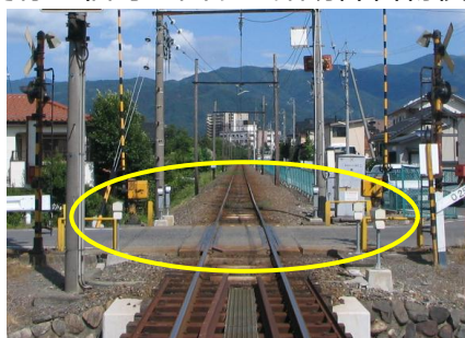
ミリ波式踏切障害物検知装置
