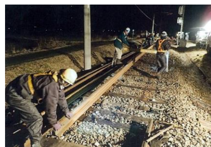
夜間軌道整備作業
