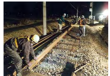
夜間軌道整備作業
