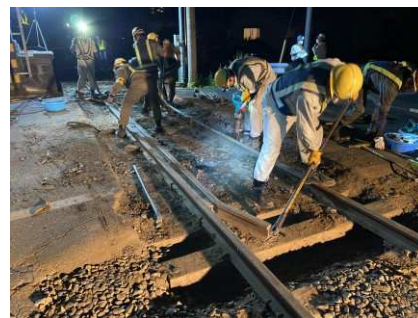
夜間軌道整備作業
