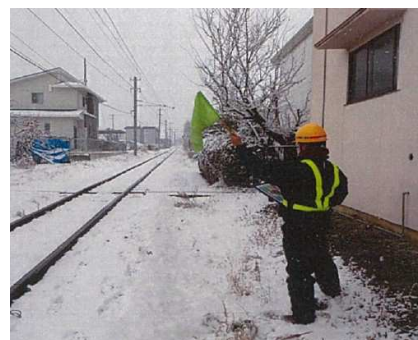
近接工事（列車見張員）
